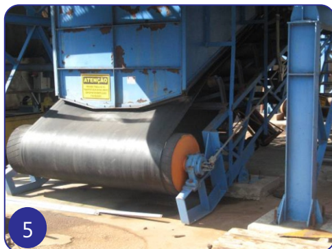
Transmissão de força desprotegida
